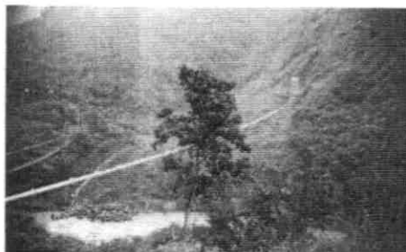
Foto 2. Se evidencia fenómenos de subsidencia y altas presiones en el macizo.
