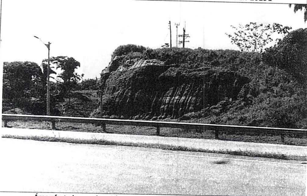
Área afectada por obras Vía Ruta al Sol – Contrato de Concesión LLK-16291
