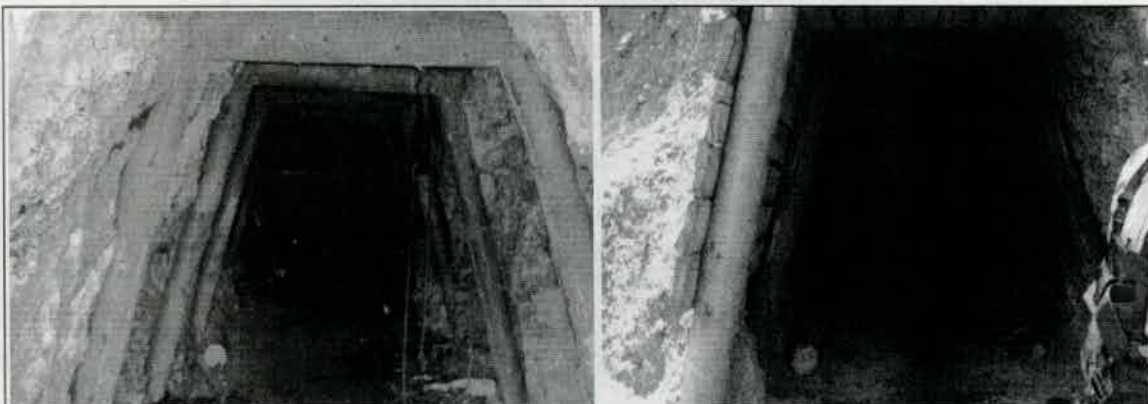
BOCAMINA, MINA LA ESPERANZA 1
