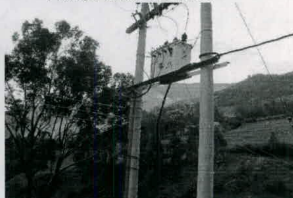
TRANSFORMADOR PROPIO
