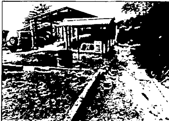
Fotografía 5. Detalle de cunetas que redirige las aguas lluvias a la quebrada Oripayera.
