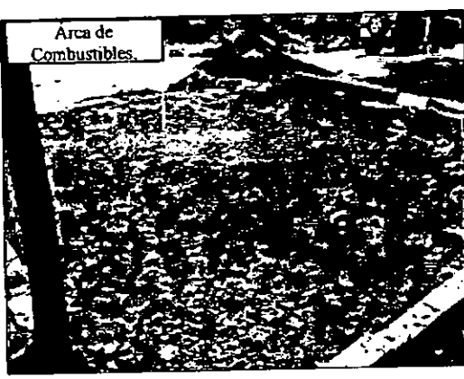
Fotografía 2. Detalle labores de retiro de arenas contaminadas por trabajador CMCT.
