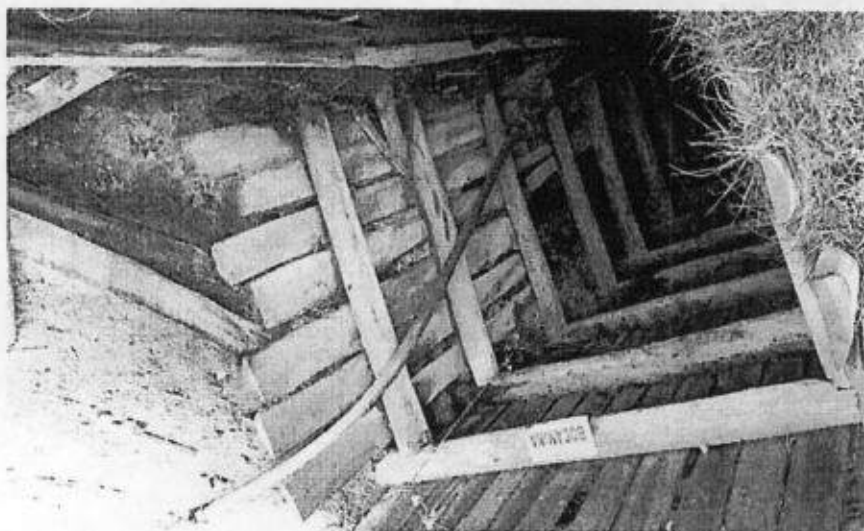
Fotografía No. 6 Bocamina de Don Javier Molano Bocamina que se ubicó fuera del área del título minero HCE-081, cuenta con un inclinado de aproximadamente de 70 metros con un rumbo N40W sostenimiento en cuadro vacenola separación entre puertas cada metro con un área libre de 4 metros cuadrados. Coordenadas N1072469.0, E 1041325.0, Alt 2845 m.s.n.m.
