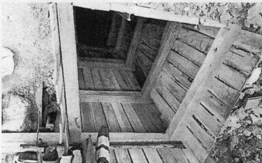
Fotografía No. 6 Bocamina de Don Javier Molano Bocamina que se ubicó fuera del área del título minero HCE-081, cuenta con un inclinado de aproximadamente de 70 metros con un rumbo N40W sostenimiento en cuadro vacenola separación entre puertas cada metro con un área libre de 4 metros cuadrados. Coordenadas N1072469.0, E 1041325.0, Alt 2845 m.s.n.m.
