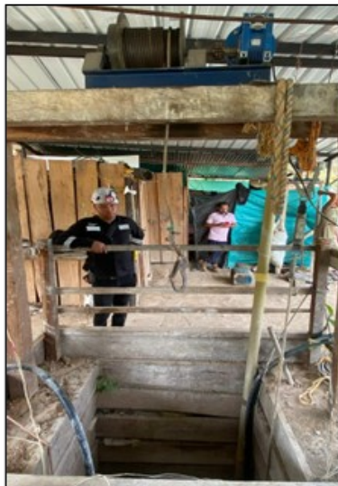
Imagen 12. Frente de explotación MINA TESORO.
