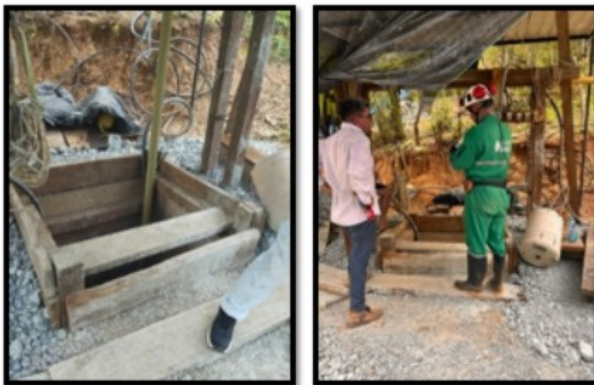
Imagen 6. Frente de explotación MINA SAN JOSE.
