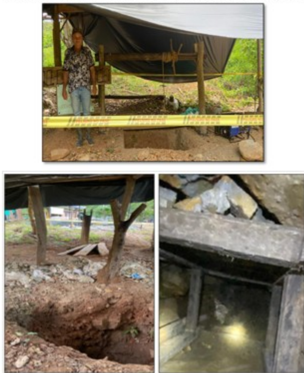
Imagen 15. Frente de explotación MINA EL DESPRECIO.
