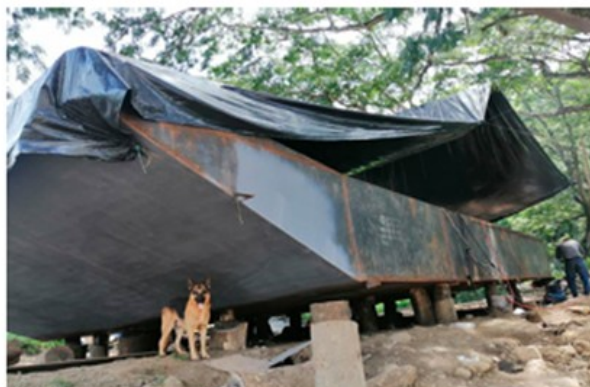
Fotografía 6. Planchón o pontón
