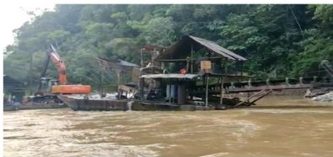
Fotografía 10. Sistema de explotación mecánico por dragado
