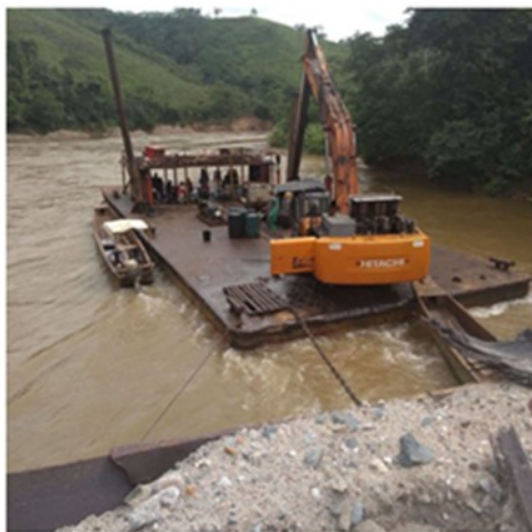
Fotografía 8. Planchón, retroexcavadora y lancha
