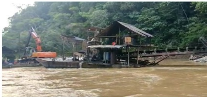
Fotografía 10. Sistema de explotación mecánico por dragado
