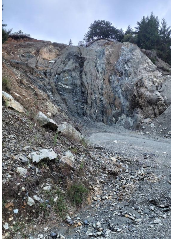
Observaciones: Frente de explotación (inactivo), con procesos erosivos superficiales.
