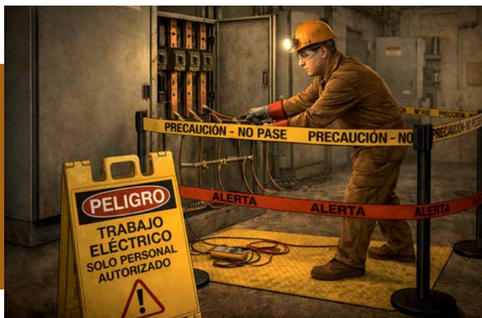
Figura 23. Área señalizada para trabajo eléctrico Fuente: imagen generada con IA Gemini (Google, 2025).
