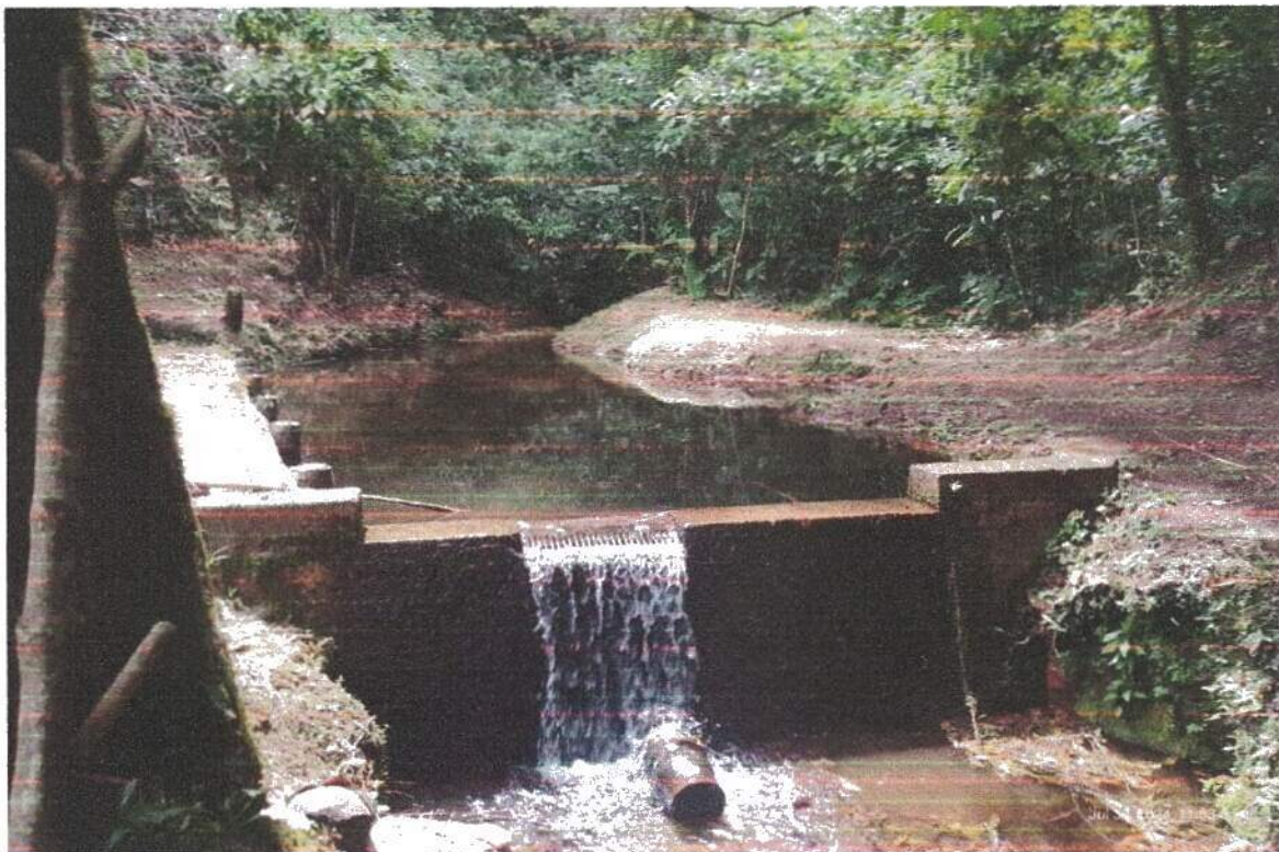
Ilustración 2 Bocatoma Quebrada la Palma.
