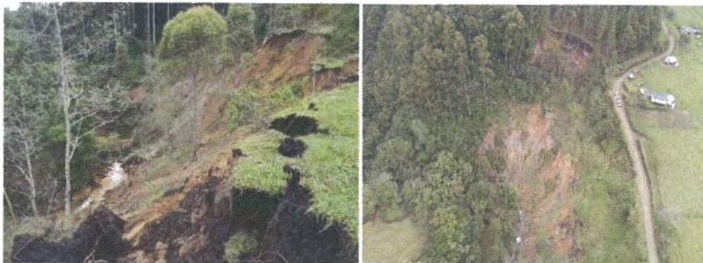
Figura 8: Procesos de remoción en masa que afecta la vía El Canelo – Casas Nuevas
